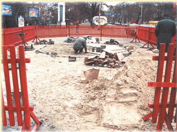
Начало работ по установке часов
