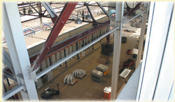
Новый котельный завод
