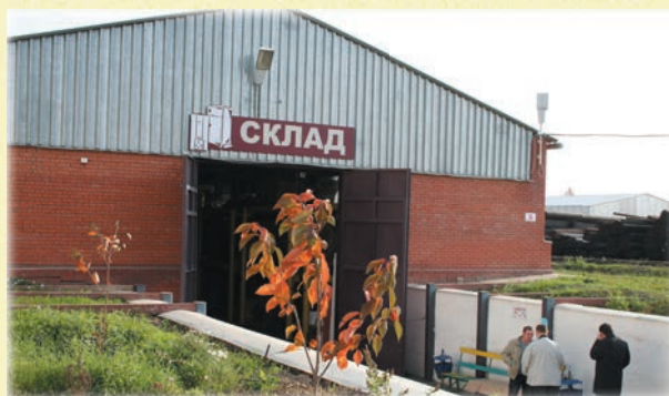
... И заполнили под крышу новый склад
