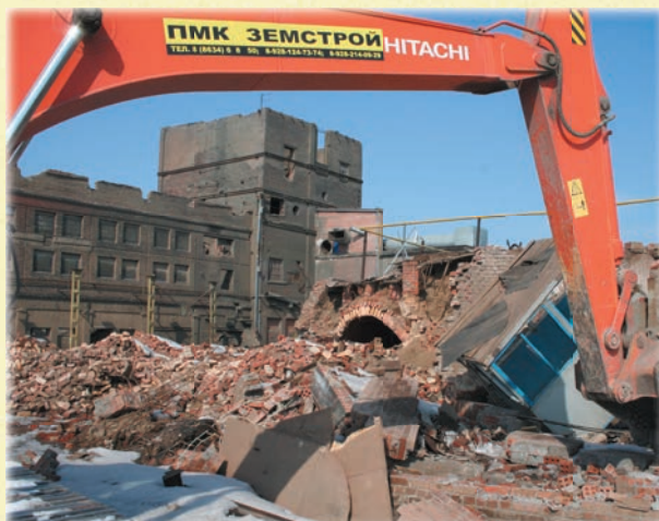
Подготовка площадей под жилищное строительство
